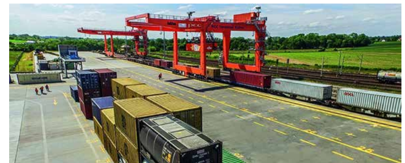
ПРИКЛАД ПОБУДОВИ СУХОГО ПОРТУ З ОДНІЄЮ ГІЛКОЮ ЗАЛІЗНИЧНОЇ КОЛІЇ
